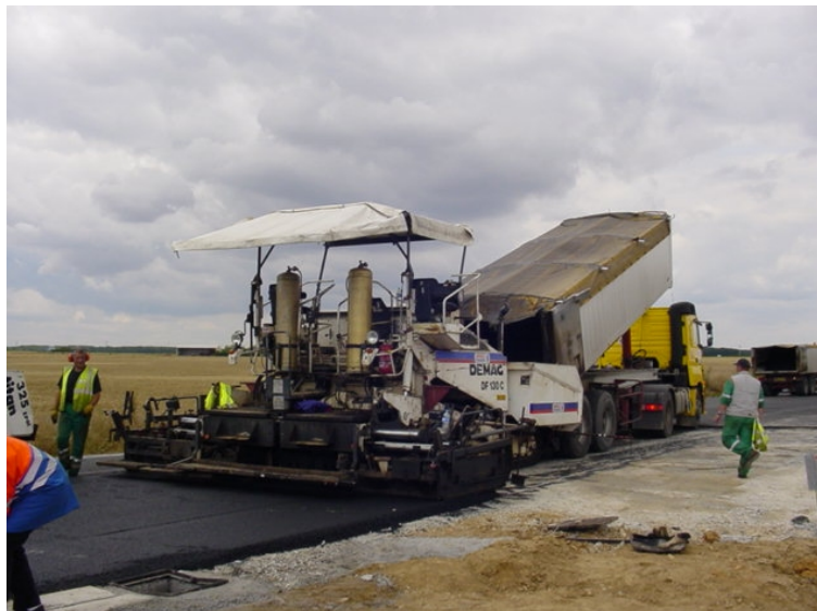
Illustration 4: Finisher : préparation de la couche de forme
