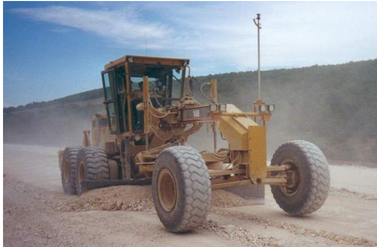
Illustration 3: Niveleuse : préparation de la couche d'assise
