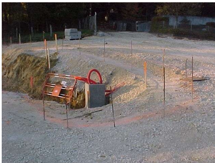
Illustration 2: Implantation des bordures
